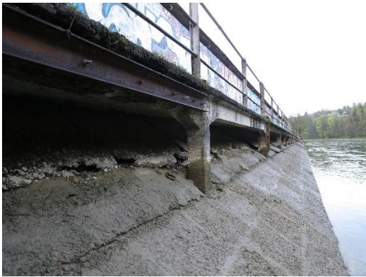
Abb. 3: Abschlussdamm und Steg auf Aareseite
