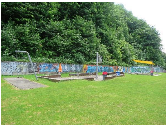
Abb. 7: Kinderspielbereich und Hangmauer
